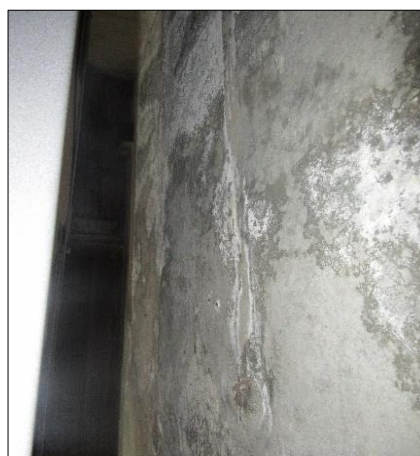
Muestra pared con Humedad CACOM 5
