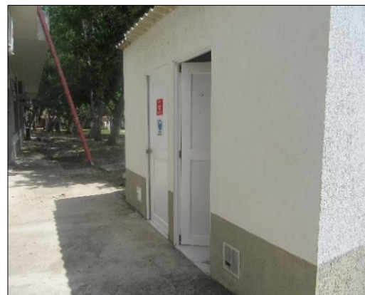
Deposito inadecuado CACOM-3
