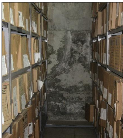
Muestra pared con Humedad CACOM 5
