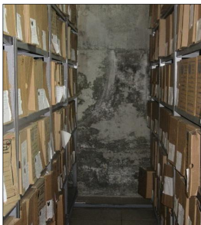
Muestra pared con Humedad CACOM 5
