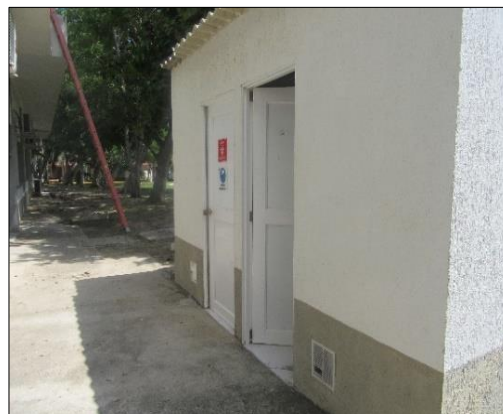
Deposito inadecuado CACOM-3
